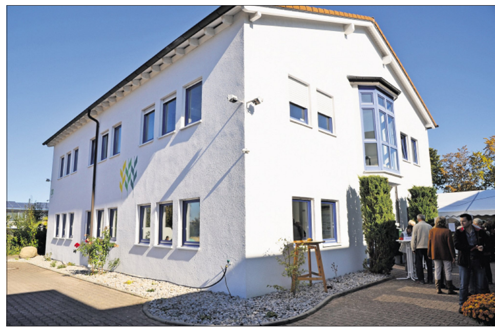
Vier Kreisbauernverbände und zwei Tochterunternehmen unter einem Dach in der Robert-Bosch-Straße in Bondorf Foto: Käthe Ruess
